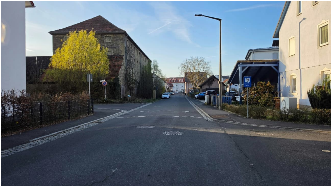
Abbildung 7: Einmündung Schulstraße / Blick aus Hofstraße von Norden
