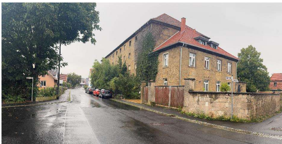
Abb. 5: Hofstraße aus Richtung der Einmündung Fabrikstraße (Aufnahme vom 10.09.2025)
